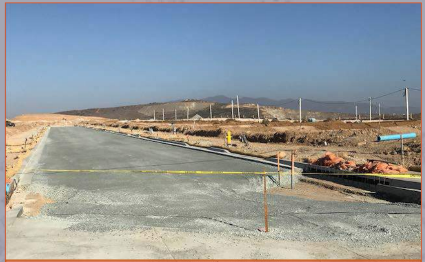
Tuyến đường đang được trải nhựa
