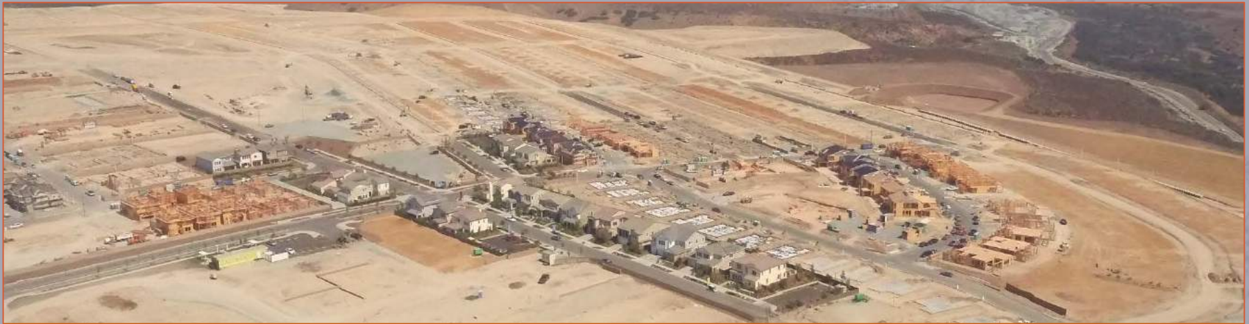
Góc nhìn từ Trung tâm thành phố ở hướng Tây của khu nhà mẫu và khu biệt thự đang trong quá trình xây dựng
