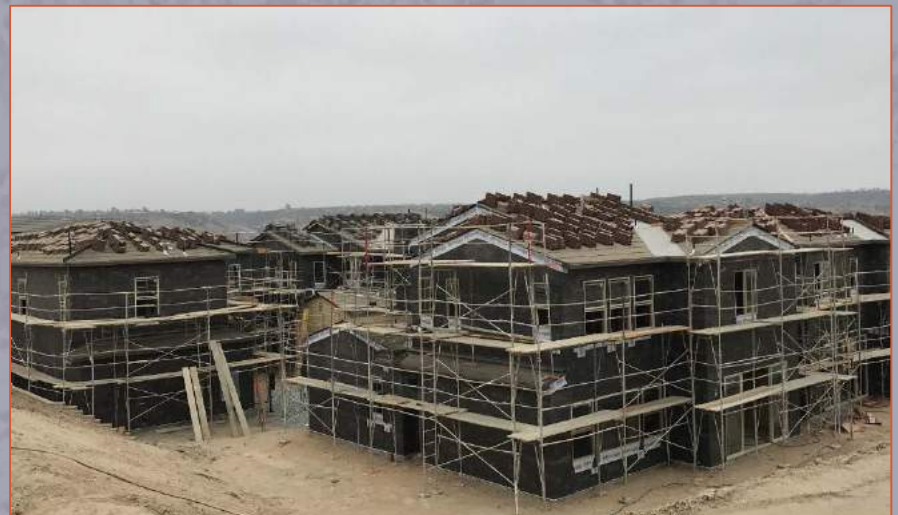
Khu biệt thự đầu tiên đã hoàn thành phần khung
